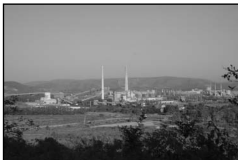
NALCO alumina refinery in Damanjodi.
